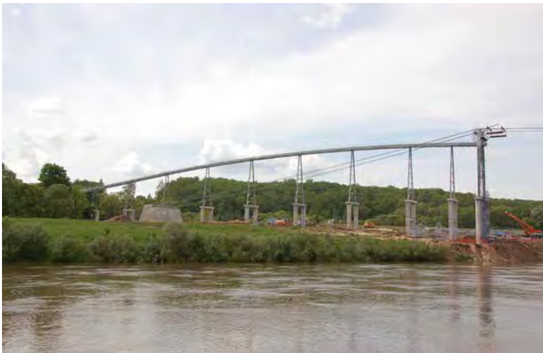
90–91. Строительство конвейерной линии для цементного завода компании «Лафарж Россия»: на правом и левом берегах Оки (2013 г.)
