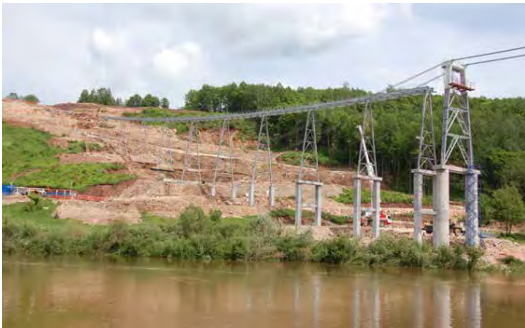
90–91. Строительство конвейерной линии для цементного завода компании «Лафарж Россия»: на правом и левом берегах Оки (2013 г.)
