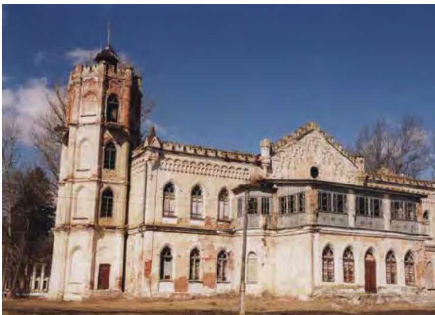
73. «Готический дом» (библиотека) в усадьбе Авчурино
